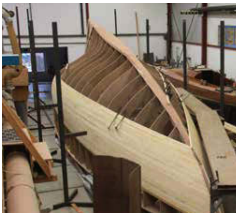
De huidlatten, voorzien van vingerlassen, worden aangebracht.
